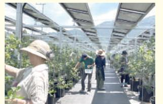
相模原市に2023年6月にオープンしたブルーベリーの摘み取り体験農園「さがみこベリーガーデン」は農地の上に隙間を開けて太陽光パネルを設置し、太陽の光を農業と発電でシェアする「ソーラーシェアリング」をおこなっています。現在272kWの発電設備があり、一般家庭約80軒分の電気を生み出しているそうです。
