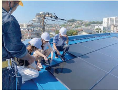
屋根の上に設置されたソーラーパネルで発電した電力は1階の防災シェルターへと配電されており、災害時にはスマートフォンなどの充電に利用することができる
