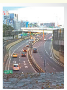
桜木町から関内にかけて地下に潜っていく高速道路
